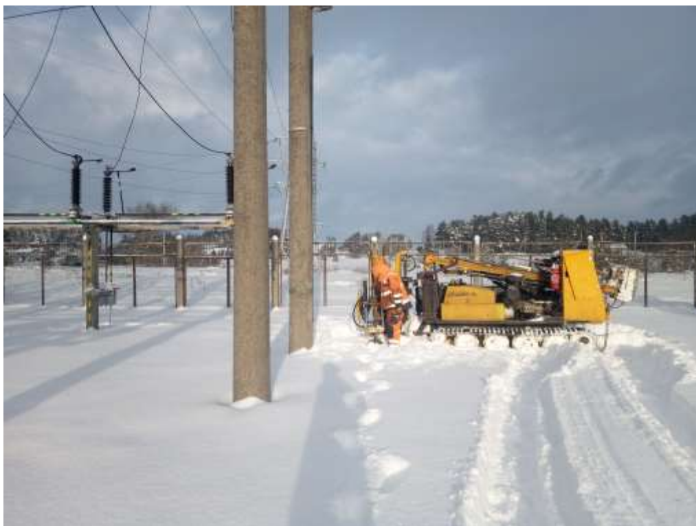
1 pav. Lauko darbai ties gręžiniu Gr.3
