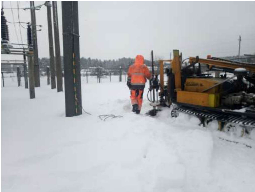
2 pav. Lauko darbai ties gręžiniu Gr.2
